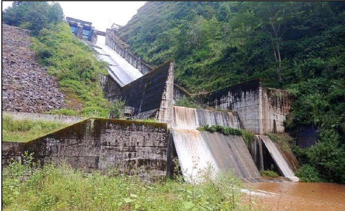
मकवानपुरको कुलेखानी जलाशय (इन्द्र सरोवर ताल) भरिँत स्थितमा पुगेपछि ओभर फ्लो पानी बाइपास सञ्चाल गरिँदो । तल भरिँत प्रपछि जलाशयको सुखती भाग अर्थात् कुलेखानी हेमि नजिक निर्माण गरिएको कुलेवाट बाइपास सञ्चाल गरिँदो । जलाशय भरिँत ५० सेन्टीमिटर भन्दा बढी भएपछि पानीको सहज छटाउन सक्दा गरिएको कुलेखानी प्रथम जलविद्युत आयोजनाले जनाएको छ । जलाशयमा पानीको सहज एक हजार ५ सय २१ सेन्टीमिटर पुगेको छ ।
