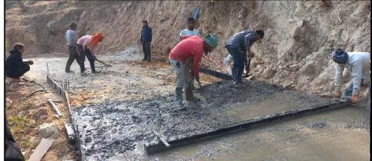
हेटौंडा उपमहानगरपालिका वडा नं. १ बैरबडाडाबाट नकीली जाने बाटो ढलान गरिँदै । यसवर्षमात्र यो क्षेत्रमा करिब एक किलोमिटर ल्याब ढलान भएको छ । तस्वीर: साझाकुरा
