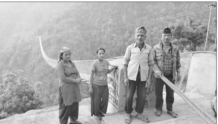
जिल्लाको उत्तरी क्षेत्रमा बाह्य नगरपालिका बडा नम्बर-११ स्थित नागदेहामा बनेको फोल्डो पुल। विगतमा फोल्डो पुल नबन्दा घण्टी हिँड्नुपर्ने बाध्यता रहेको थियो। अहिले पुल बन्दा बाह्य नगरपालिका बन्ने अवसर प्राप्त भएको छ।
