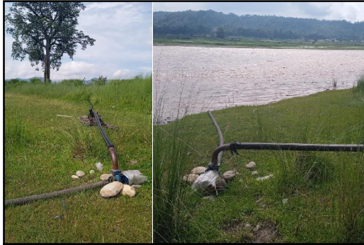
बागमती नदीको धार परिवर्तन हुँदा हालसम्म तीन पटक मुहान परिवर्तन भइसकेको छ । ०५०/०५२ सालमा पहिलो पटक मुहान निर्माण भएको थियो ।
