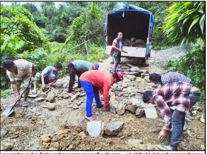
बाग नगरपालिका-११ स्थित नैबहुडेमा सवारीसाधन चलाउन सडक बनाउँदै स्थानीय युवाहरू। यहाँ लागेको जीर्ण संस्कारको सडकमा सवारी चलाउन मुस्किल भएपछि स्थानीयस्तरमै उपलब्ध ढुंगा ल्याएर सडकमा बिथ्याउने काम भइरहेको ११ नम्बर वडाका निर्वाहमान वडा अध्यक्ष किशोरमान बज्रले बताए। स्थानीय किसानको तरकारी बुझाउने गरी बजारसम्म सैमानि मूख बढाउने काम भइरहेको ११ नम्बर वडामा नैबहुडेमा सडक हुने उक्त सडक छिमेकी जिल्ला धरिइन्द्र छ। सडक पक्की नभएका कारण यहाँमा आउने पानीको भेलेले सडक विनाश गरेको छ।
