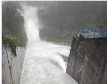
शनिवार विहान तामाकोशी जस्ता ठूला आयोजनाको विद्युत् उत्पादन बन्द हुँदा कुलेखानी जलाशयमा १ हजार ५३१ मिटर पुगेको थियो । कुलेखानीमा १ हजार ५३० मिटर मात्र पानी सक्नन गर्ने क्षमता रहेको छ । क्षमता भन्दा बढी पानी भरिपछि जलाशय स्वतः ओभरफ्लो हुने गर्दछ । ओभरफ्लो भएपछि कुलेखानी जलाशयको २ वटा ढोका शनिवार विहान ४ मिटरसम्म खोलिएको थियो ।
